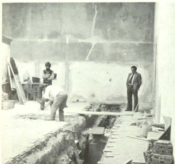
Fig. 1 — Um aspecto da escavação
