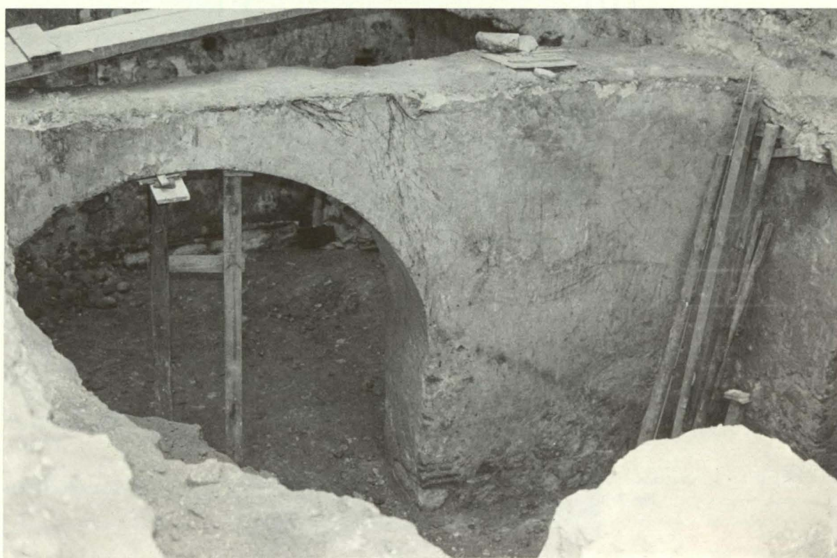
Fig. 9 — Parede constituída por materiais de aproveitamento: face voltada à R. da República, depois de retirado o reboco
