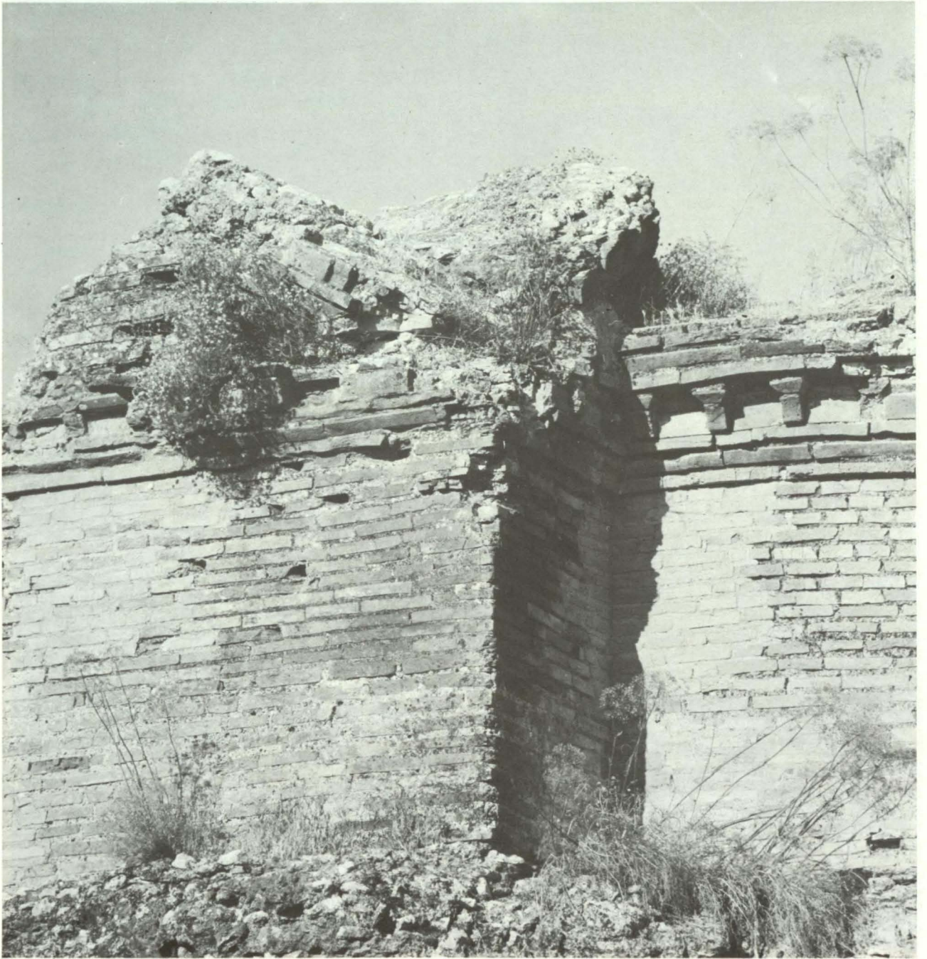
Fot. 8 — Cornija no canto Sudoeste da cella
