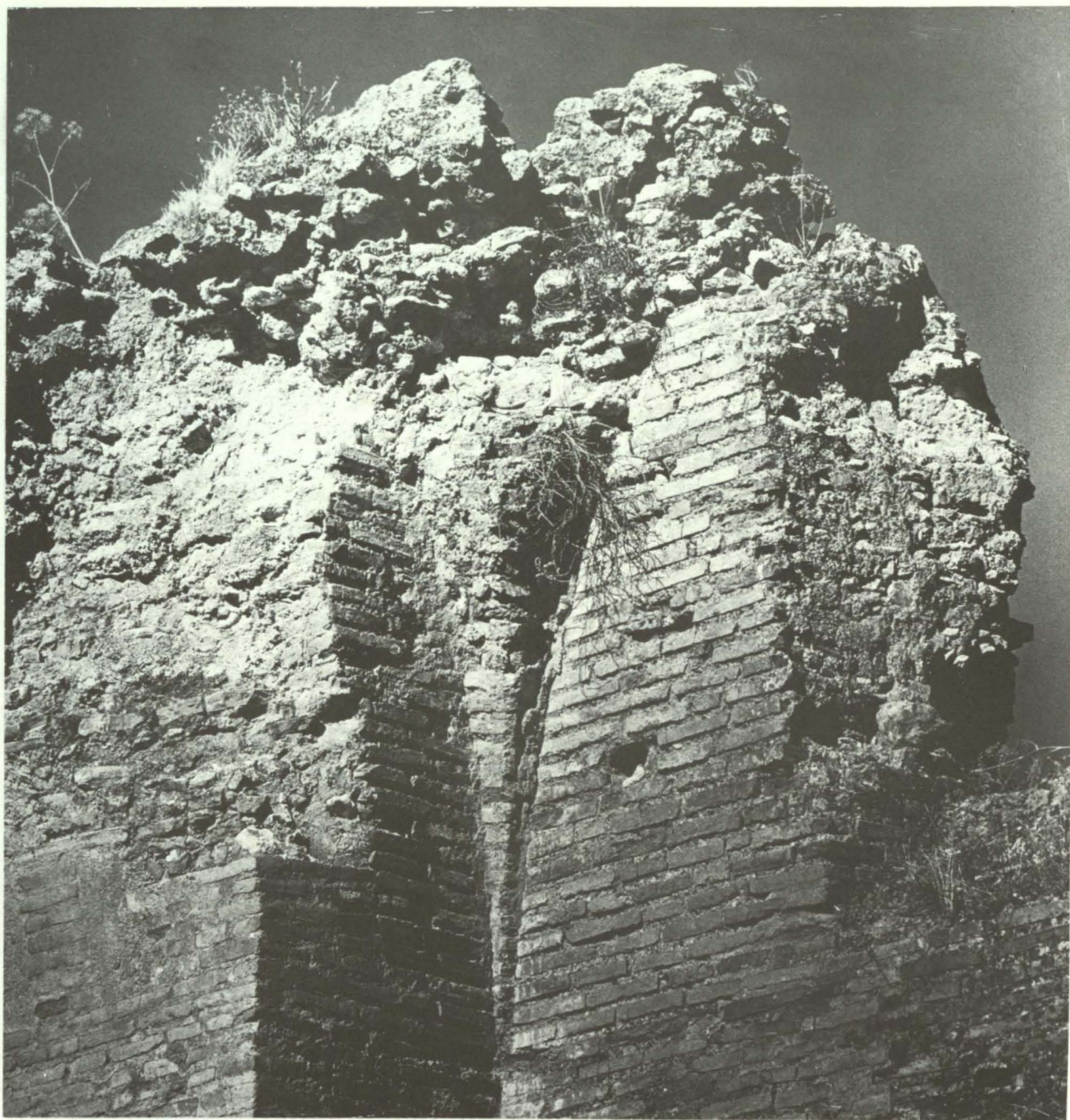
Fot. 6 — Arranque da abóboda ocidental na cella . À direita vê-se o resto do canto da janela
